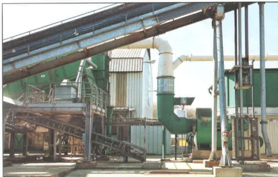
Figure 1 – Unité de traitement de Scoribel, filiale belge d'Holcim, spécialisée dans le prétraitement des déchets industriels afin de les transformer en combustibles pour l'industrie du ciment
