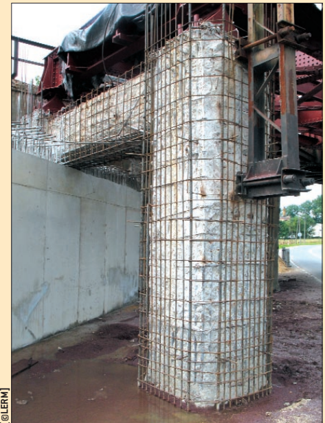
La réparation d'un ouvrage très corrodé peut nécessiter un recalcul de sa structure et éventuellement un renforcement général.
