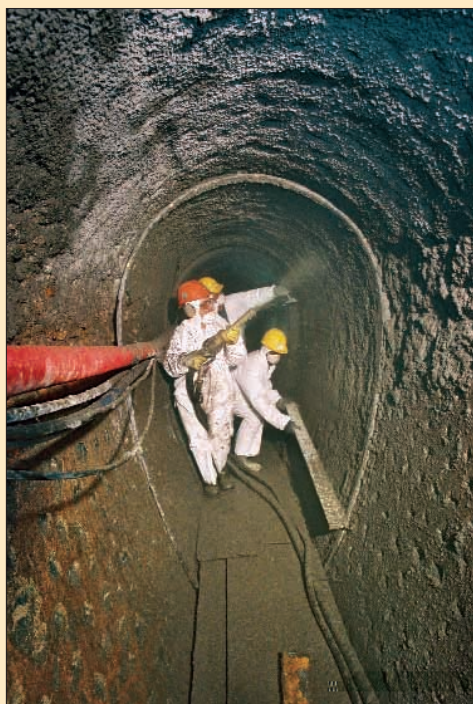
Réhabilitation d'un réseau d'assainissement.
