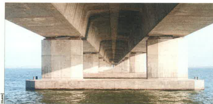
Sous-face et alignement des piles d'appui du viaduc central.
