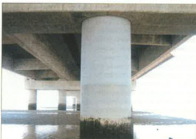
Mise en œuvre d'un revêtement de protection à titre préventif sur une colonne du viaduc sud.
