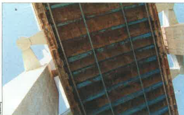
Sous-face du tablier du pont principal à haubans.
